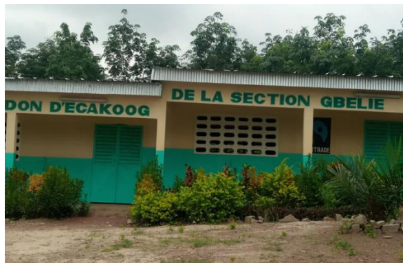
Bâtiment scolaire à la section Gbelié
